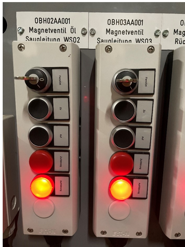
Abb. 20: Beispiel für die Armaturen-Signalisierung(siehe Abbildung 20)
