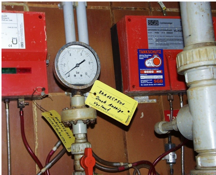
Abb. 4: Vorfeld-Beschriftung für einen Druckmesser
