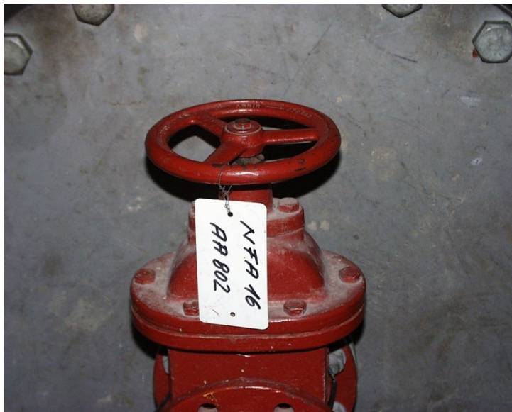
Abb. 5: Vorfeld-Beschriftung für ein Ventil
