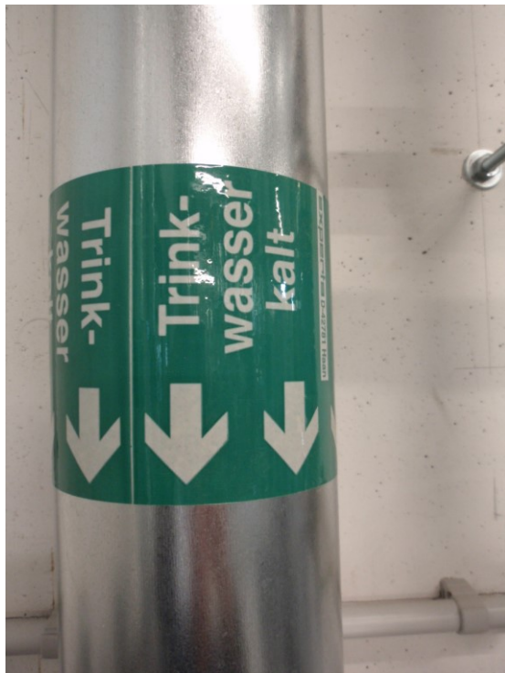
Abb. 10: Folienband an einer Rohrleitung zur Kennzeichnung des Durchflusstoffs und der Durchflussrichtung
